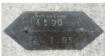
Repère de crue (janv. 1995) Guipry
