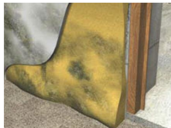
DÉGRADATION D'UN DOUBLAGE ISOLANT (source Ministère de l'écologie)
